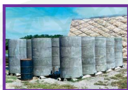
ภาพที่ 1 การฝังกลบประยุกต์ โดยใช้บ่อคอนกรีตชนิดกลม (ถังส้วม) ที่มีขายในท้องตลาด
