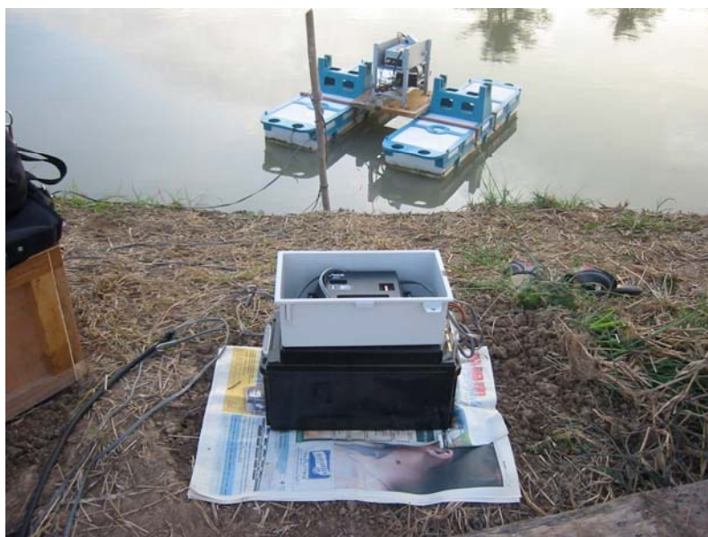
ภาพที่ 30 การติดตั้งอุปกรณ์ของระบบ
