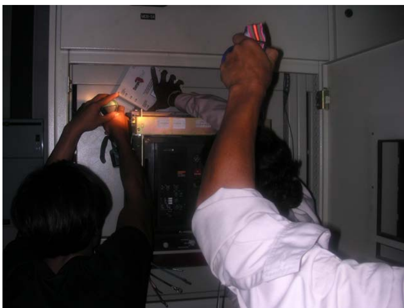
ภาพผนวกที่ 17 ติดตั้ง SPD ก่อน ACB โดยขนานกับระบบไฟฟ้า
