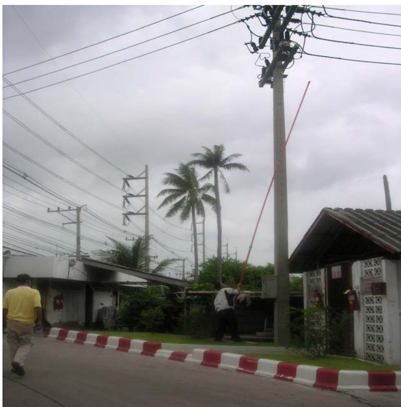
ภาพผนวกที่ 16 ปลด ครอบเอา ฟิวส์ของไฟฟ้าแรงสูง
