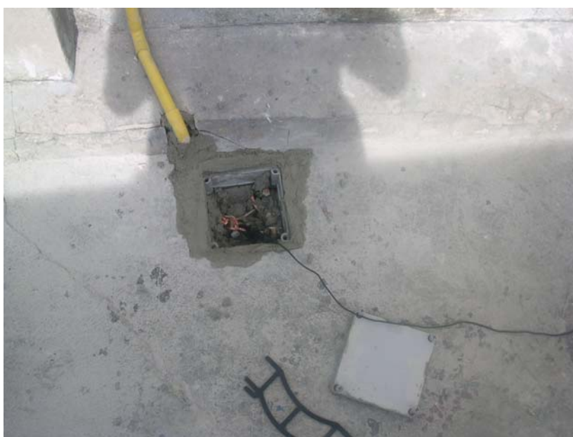
ภาพผนวกที่ 21 บ่อกราวด์ที่ใช้ฝังหลักดิน
