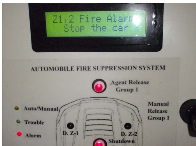
ภาพที่ 38 แสดงการส่งนิตสารดับเพลิงในพื้นที่ห้องเครื่องยนต์หลังตัดการทำงานของเครื่องยนต์
