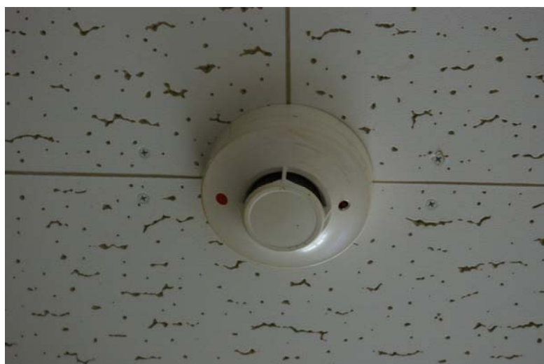
ภาพที่ 9 อุปกรณ์ตรวจจับควันไฟแบบพลังแสง (Photoelectric Spot Type Smoke Detector)
