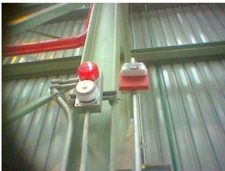
ภาพที่ 13 อุปกรณ์แจ้งเตือนแบบสัญญาณเสียง (Strobe with Horn Alarm device)
