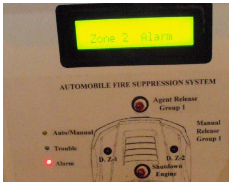
ภาพที่ 21 แสดงการทดสอบการทำงานของอุปกรณ์วัดความร้อนโซนที่ 2
