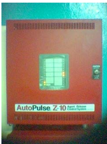
ภาพที่ 14 ตู้ควบคุม (Fire releasing control panel)
