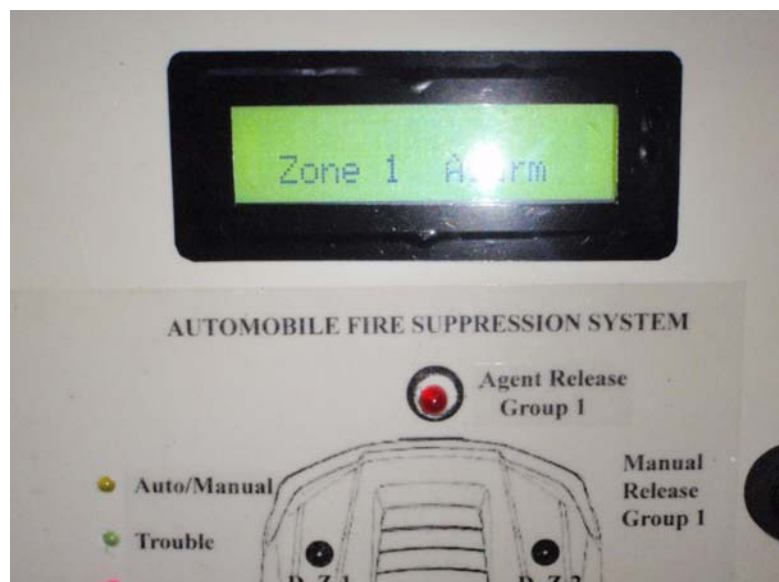
ภาพที่ 36 แสดงการทดสอบตัววัดอุณหภูมิในตำแหน่งที่ 1 พร้อมแสดงสถานะ Alarm
