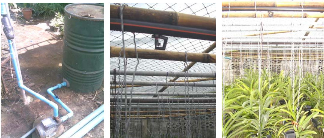
ภาพผนวกที่ ก13 การติดตั้งปั๊มและระบบท่อในแปลงทดลองเปรียบเทียบผลการเจริญเติบโตของกล้วยไม้จากการใช้วิธีการให้น้ำต่างกัน สำหรับหัวจ่ายน้ำมินิสปริงเกอร์
