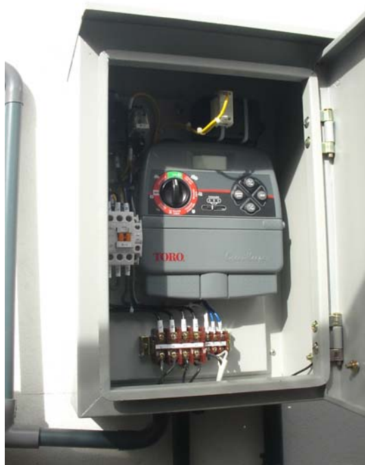
ภาพผนวกที่ ก11 สำหรับแปลงทดลองหัวจ่ายน้ำไมโครสปริงที่มีการติดตั้งเครื่องตั้งเวลาเพื่อควบคุมเวลาในการให้น้ำ
