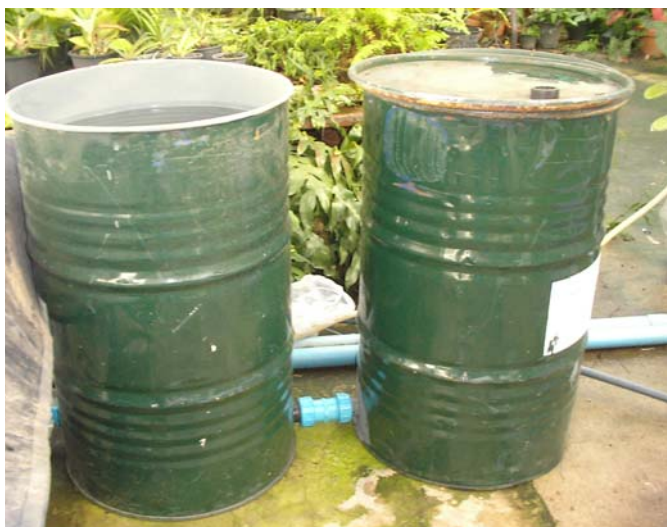
ภาพที่ 14 ถังใส่น้ำ 2 ใบต่อเชื่อมกันสำหรับต่อกับปั้มน้ำ
