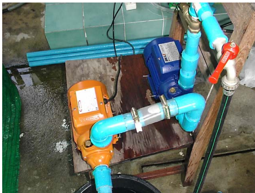
ภาพผนวกที่ ก3 การต่อปั๊มในลักษณะอนุกรมสำหรับทดลองความสม่ำเสมอของละอองน้ำเมื่อใช้หัวจ่ายน้ำ DAN สีน้ำเงินและ DAN สีส้ม เนื่องจากต้องการแรงดันใช้งาน 4 บาร์
