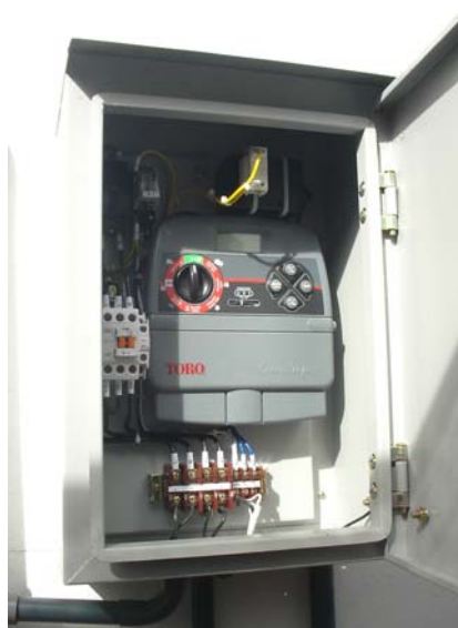
ภาพที่ 15 เครื่องตั้งเวลาและตู้ควบคุม สำหรับตั้งเวลาการให้น้ำในแปลงระบบการให้น้ำด้วยหัวจ่ายน้ำไมโครสเปรย์
