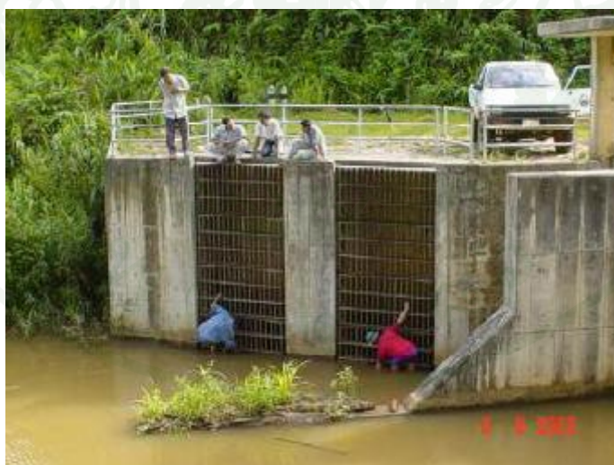
ภาพที่ 22 อาคารรับน้ำโครงการไฟฟ้าพลังน้ำห้วยน้ำขุ่น
