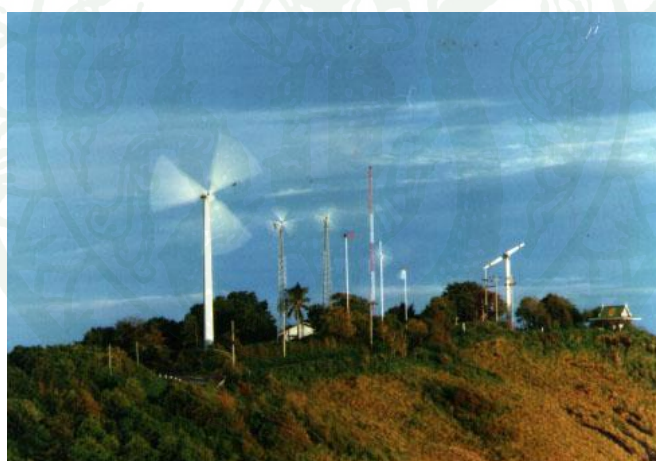
ภาพที่ 10 สถานีผลิตไฟฟ้าร่วมที่แหลมพรหมเทพจังหวัดภูเก็ต
