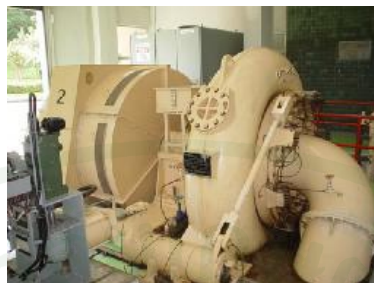
ภาพที่ 25 เครื่องกังหันน้ำและเครื่องกำเนิดไฟฟ้าแบบฟรานซิส
