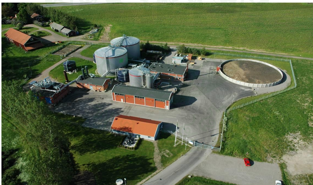
ภาพที่ 47 โรงไฟฟ้าพลังงานก๊าซชีวภาพ
