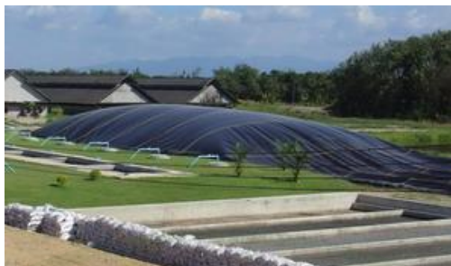
ภาพที่ 52 ระบบบ่อปิด (Covered Lagoon)
