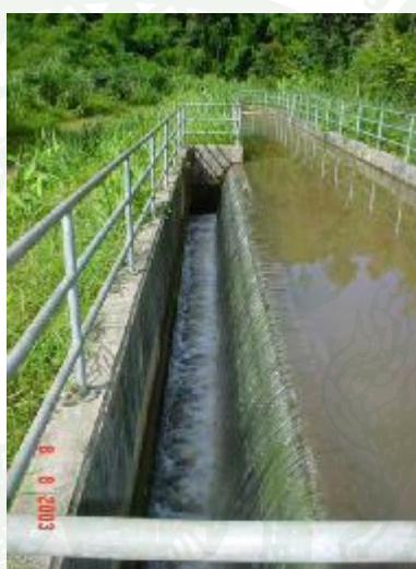
ภาพที่ 23 บ่อพักน้ำ โครงการไฟฟ้าพลังน้ำห้วยน้ำขุ่น
