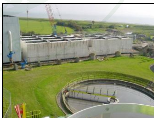
ภาพที่ 57 ระบบผลิตก๊าซชีวภาพแบบ Up flow Anaerobic Sludge Blanket
