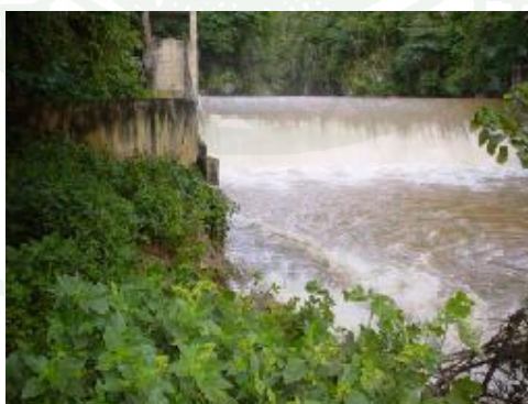
ภาพที่ 21 ฝายทดน้ำโครงการไฟฟ้าพลังน้ำแม่ฮ่องสอน
