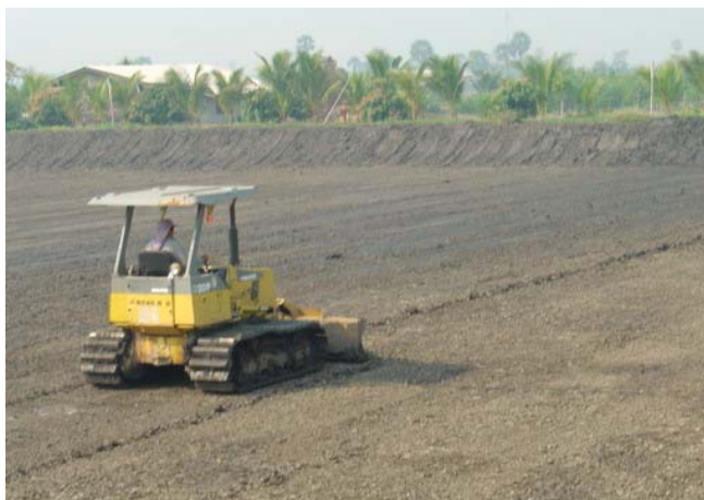
ภาพที่ 1 นำเลนกลางบ่อออกจากบ่อและปรับระดับพื้นบ่อ
