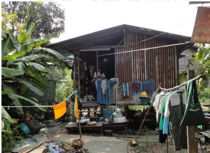
ภาพที่ 11 ลักษณะอาคารที่พักอาศัยโครงสร้างไม้
