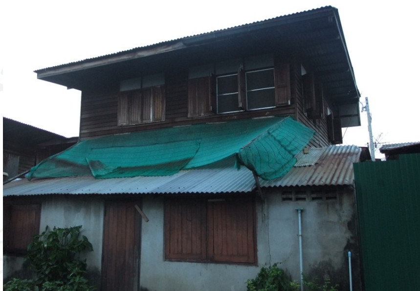
ภาพที่ 9 ลักษณะอาคารที่พักอาศัยชั้นที่ 1 โครงสร้างปูน ชั้นที่ 2 โครงสร้างไม้
