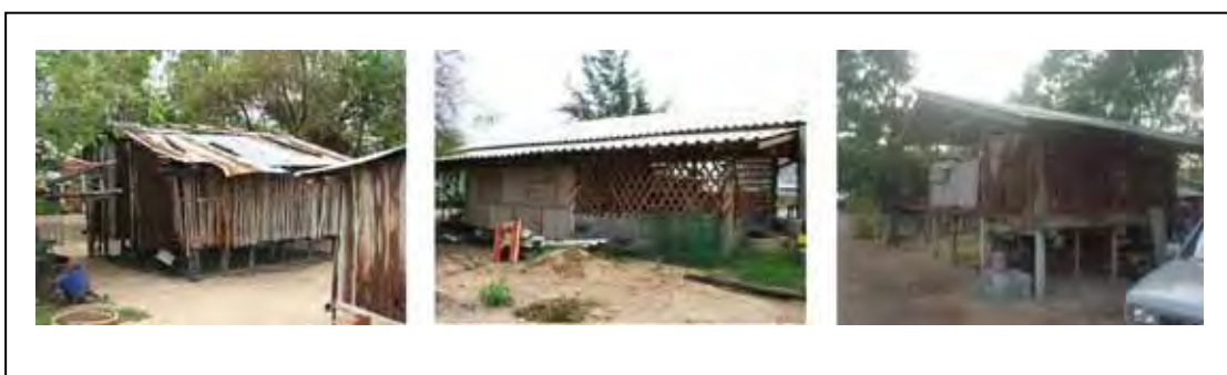
ภาพที่ 14 การนำวัสดุเหลือใช้มาทำฝาผนังโปร่งเป็นส่วนหนึ่งของสถาปัตยกรรมพื้นถิ่น
