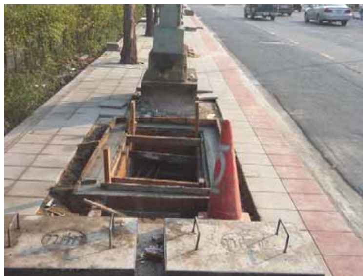
ภาพที่ 17 การสร้างบ่อพัก (PB#) ท่อร้อยสายโทรศัพท์ใต้ดิน ในทางเท้า
