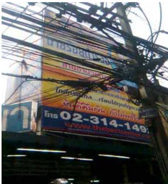
ภาพที่ 4 แนวสายเคเบิลอากาศแบบเดิมที่เกาะเสาไฟฟ้าเกินขนาด เพื่อกำหนดจำนวนท่อ (สถานที่ บริเวณถนนรามคำแหง)
