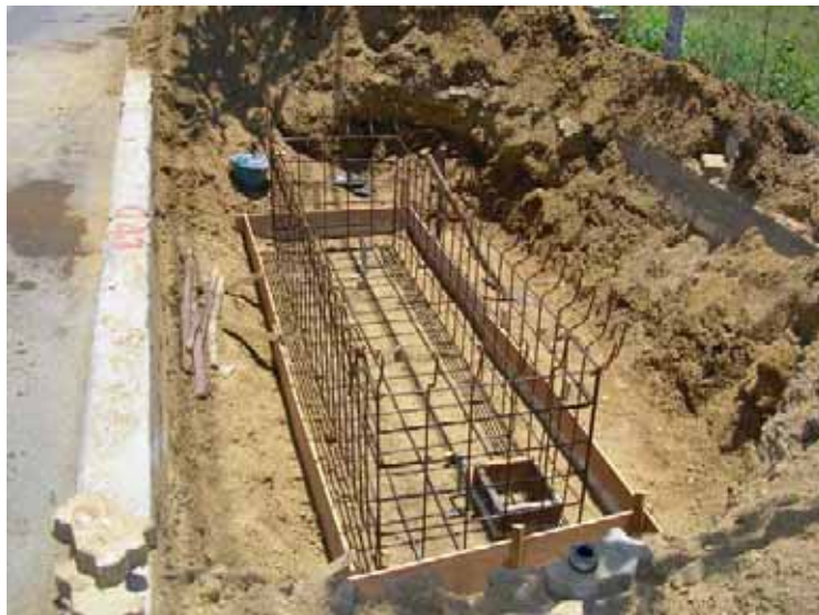
ภาพที่ 16 โครงเหล็กประกอบการสร้างบ่อพัก (PB#) ท่อร้อยสายโทรศัพท์ใต้ดิน ในทางเท้า
