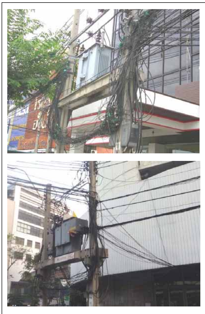
ภาพที่ 1 สำรวจแนวสายเคเบิลอากาศแบบเดิมที่ผ่านหม้อแปลงไฟฟ้า
