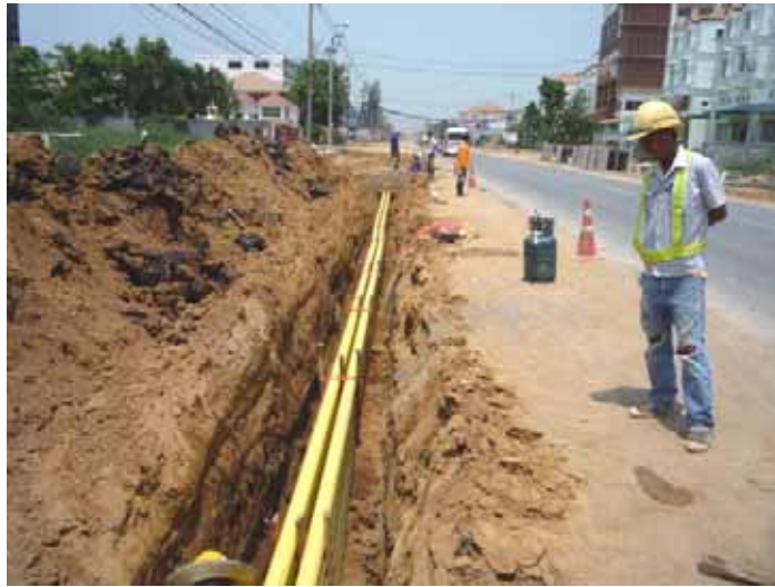
ภาพที่ 14 การก่อสร้างการวางท่อในผิวจราจร
