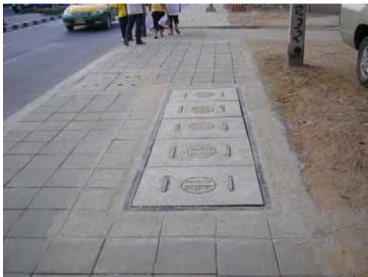
ภาพที่ 18 การดำเนินการก่อสร้างแล้วเสร็จ
