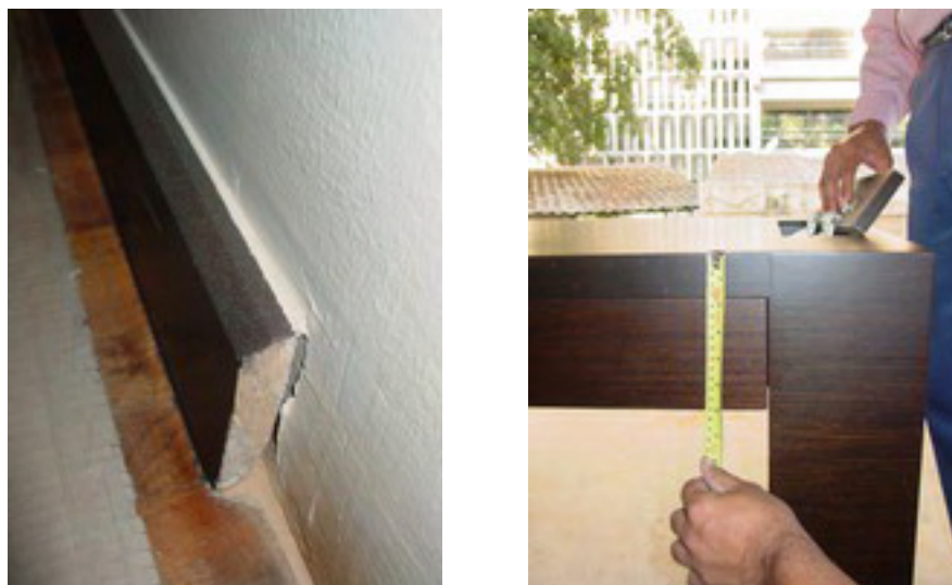
ภาพที่ 33 ข้อผิดพลาดของชิ้นงานที่เกิดจากงานไม้
