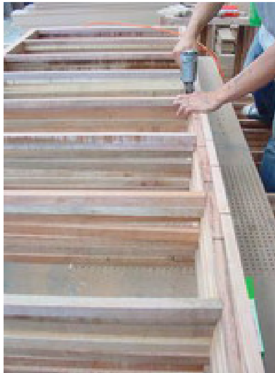
ภาพที่ 11 การเตรียมโครงไม้และแผงไม้
