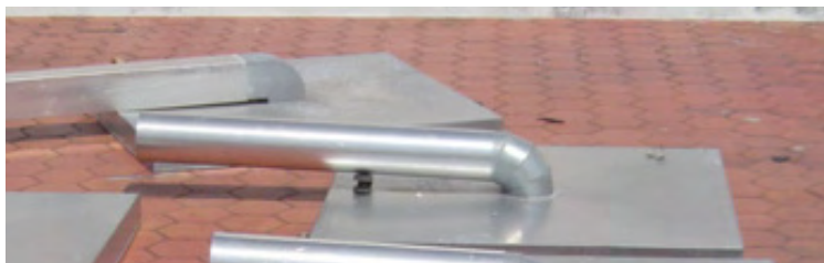
ภาพที่ 75 แสดงท่อนำแสงแบบรูปทรงกระบอก ความยาว 90 เซนติเมตร
