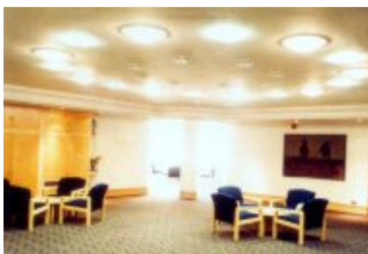
ภาพที่ 13 แสดงการใช้ระบบท่อนำแสงในพื้นที่โถงและห้องประชุม
