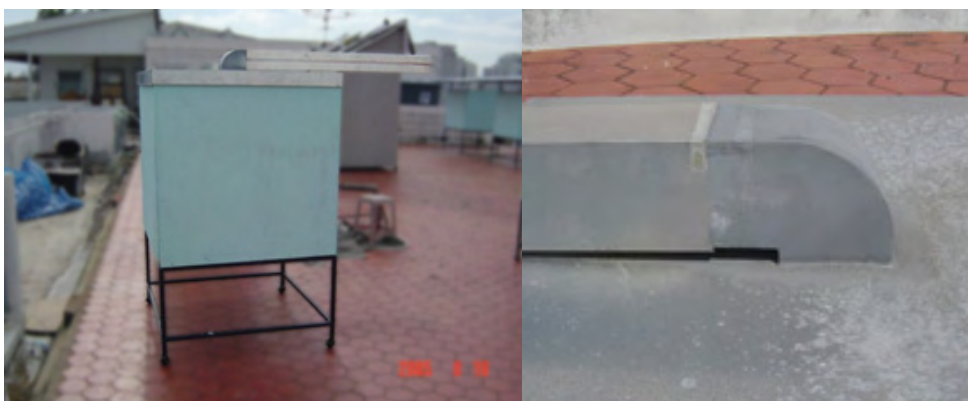
ภาพที่ 63 แสดงท่อนำแสงแบบท่อสี่เหลี่ยมจัตุรัสข้อต่อโค้ง ยาว 1.20 เมตร
