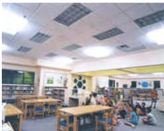
ภาพที่ 12 แสดงการใช้ระบบท่อนำแสงในโรงเรียน
