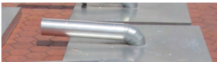
ภาพที่ 74 แสดงท่อนำแสงแบบรูปทรงกระบอก ความยาว 60 เซนติเมตร
