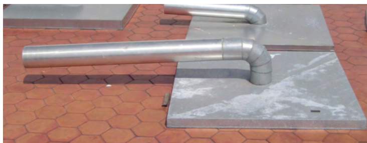
ภาพที่ 76 แสดงท่อนำแสงแบบรูปทรงกระบอก ความยาว 120 เซนติเมตร
