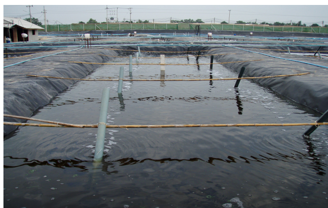
ภาพที่ 3 บ่อทดลองขนาด 50 ตารางเมตร ปูด้วยพลาสติกดำ (PE) ทั่วทั้งบ่อ
