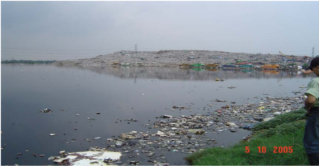
ภาพที่ 7 บ่อกักเก็บน้ำชะขยะที่มีปริมาณถึง 400,000 ลูกบาศก์เมตร ในพื้นที่ 45 ไร่ (5 ต.ค. 2548)
