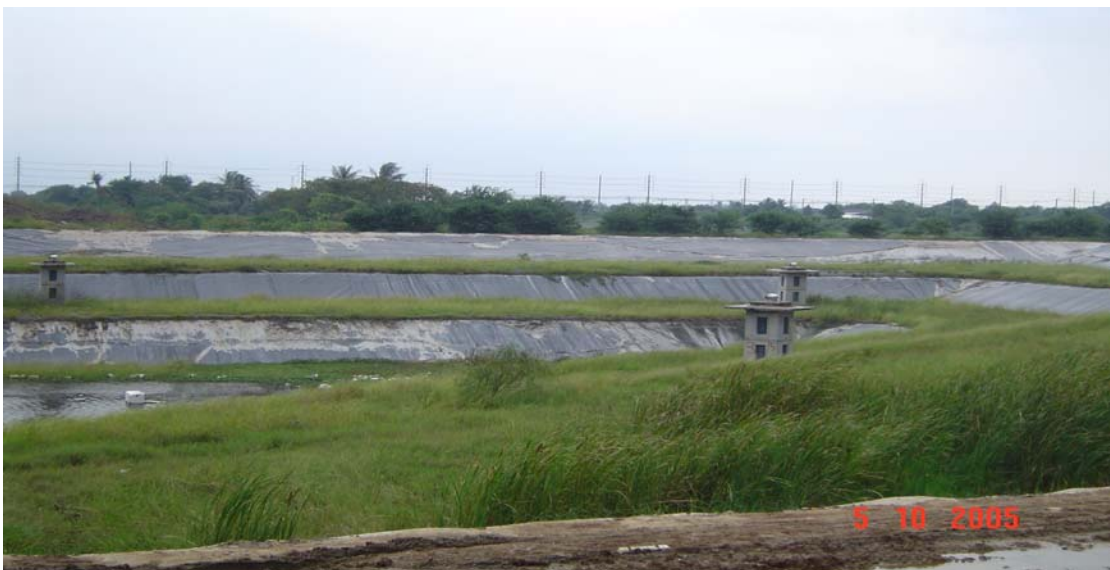
ภาพที่ 8 บ่อฝังกลบขยะบ่อใหม่ที่กำลังอยู่ในขั้นตอนของการก่อสร้างและดำเนินการ (5 ต.ค. 2548)
