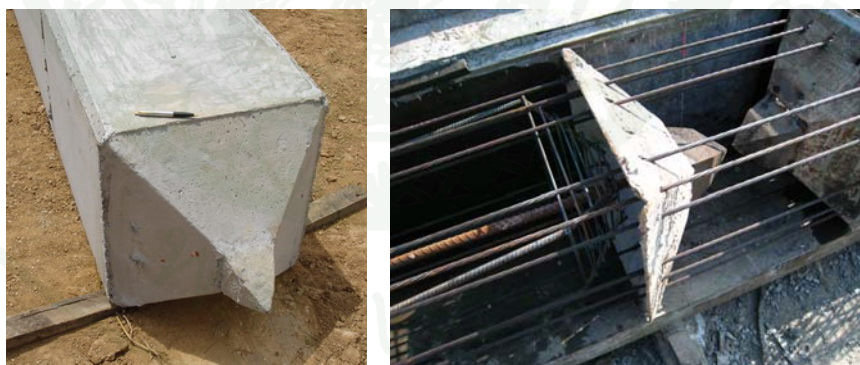
ภาพที่ 43 ลักษณะเสาเข็มและหัวสวมเหล็กของเสาเข็มที่ใช้ในโครงการ (ศูนย์วิจัยและพัฒนาวิศวกรรมปฐพีและฐานราก ม.เกษตรศาสตร์)
