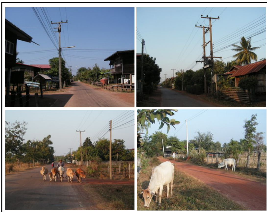
ภาพที่ 21 การจ่ายกระแสไฟฟ้าภายในชุมชนบ้านเป็น
