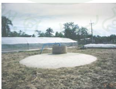
ภาพที่ 3 ระบบบำบัดก๊าซชีวภาพแบบโดมคงที่
