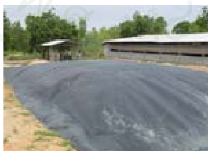
ภาพที่ 4 ระบบบำบัดก๊าซชีวภาพแบบพลาสติกคลุมบ่อ ที่มา: กรมควบคุมมลพิษ (2549)
