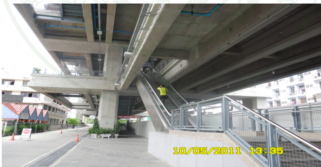
ภาพที่ 10 สถานีพญาไท ไม่มีที่จอดรถ สามารถจอดรถได้เพียงชั่วคราว
