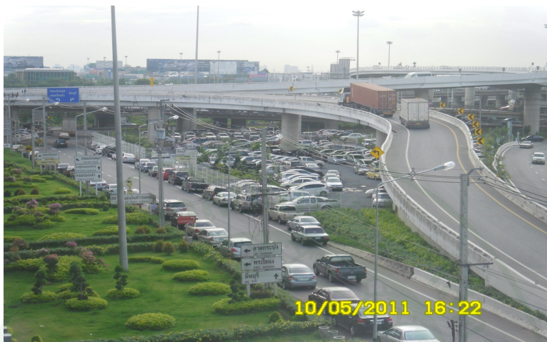
ภาพที่ 23 สถานีลาดกระบัง มีที่จอดรถไม่เพียงพอต่อความต้องการ ในบริเวณที่จอดรถคนในพื้นที่ เท่านั้นที่ทราบว่าเป็นที่จอดรถของ Airport Rail Link และบริเวณที่จอดรถอยู่ห่างจากตัว สถานีเป็นระยะทางประมาณ 300 เมตร
