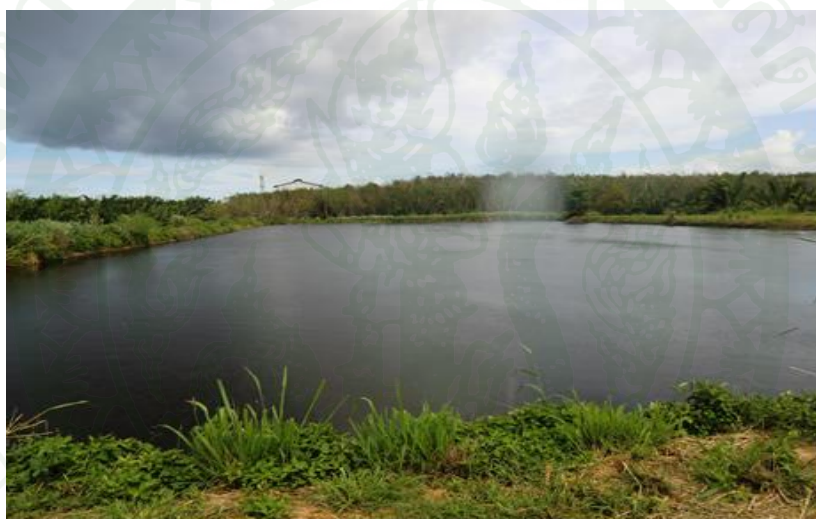
ภาพที่ 10 ลักษณะของบ่อน้ำทิ้งสุดท้ายจากโรงงานสกัดปาล์มน้ำมันดิบ
