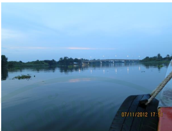
ภาพที่ 16 ลักษณะพื้นที่ของสถานีที่ 13 สะพานบางยางรุ่งสกินพัฒนา อำเภอกระทุ่มแบน จังหวัดนครปฐม
