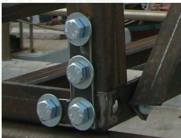
ภาพที่ 21 ลักษณะแผ่นเหล็กฉากที่ช่วยเสริมความแข็งแรงบริเวณมุมให้กับปะการังเทียม
