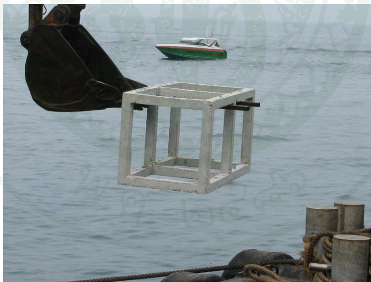
ภาพที่ 13 ปะการังเทียมคอนกรีตที่นิยมใช้สร้างเป็นปะการังเทียมในปัจจุบัน
