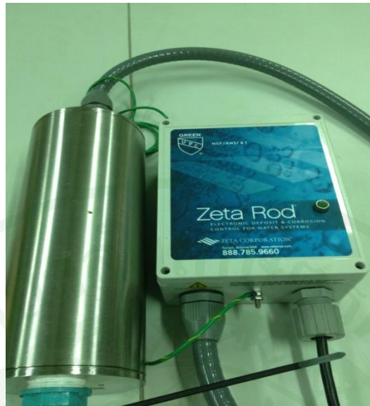
ภาพผนวกที่ ข1 เครื่องกำเนิดประจุไฟฟ้าขี้หื้อ Zeta rod
