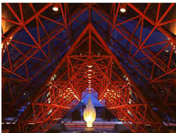
ภาพที่17แสดงโครงหลังคาโถงทางเข้าอาคาร
