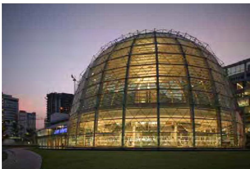
ภาพที่ 4 ภาพอิทธิพลจากบรรยากาศและโครงสร้างสถาปัตยกรรม
