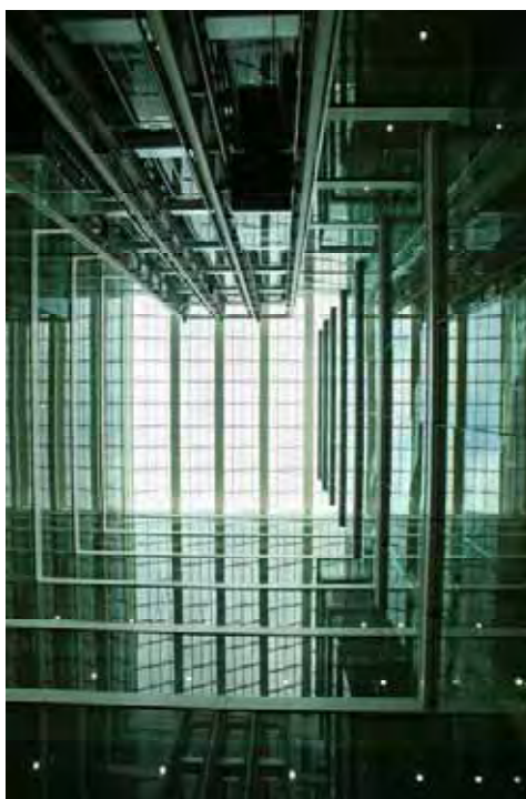
ภาพที่ 2 ภาพอิทธิพลจากบรรยากาศและโครงสร้างสถาปัตยกรรม
