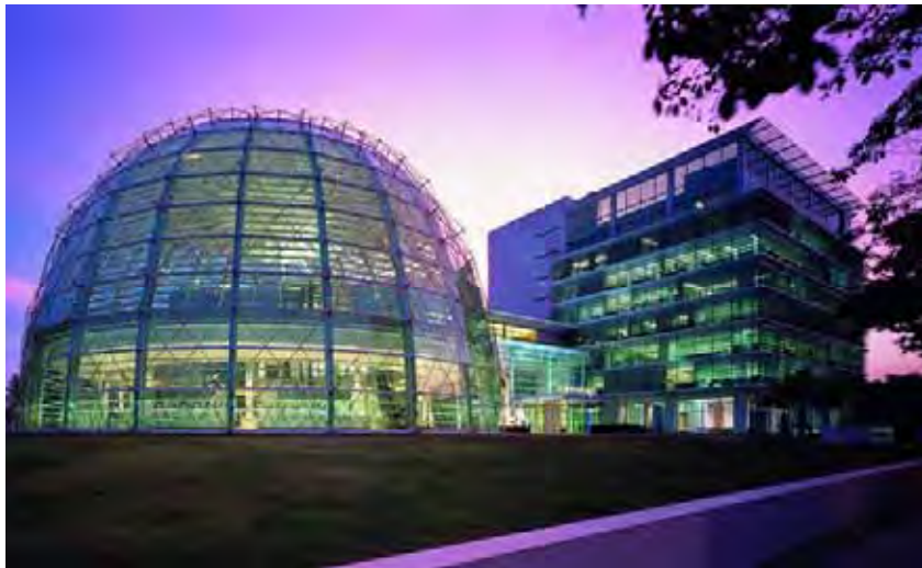
ภาพที่ 18 ภาพ อาคาร King Power Complex
