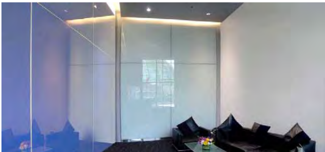
ภาพที่ 61 ภาพบริเวณติดตั้งห้องรับรอง 1
