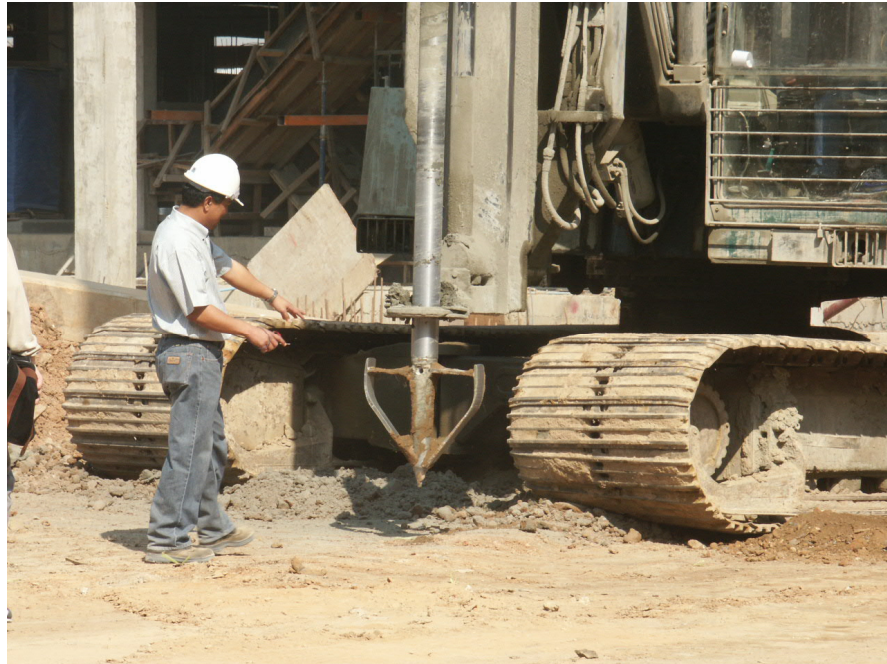
ก) หัวเจาะระบบ Dry Mixing
