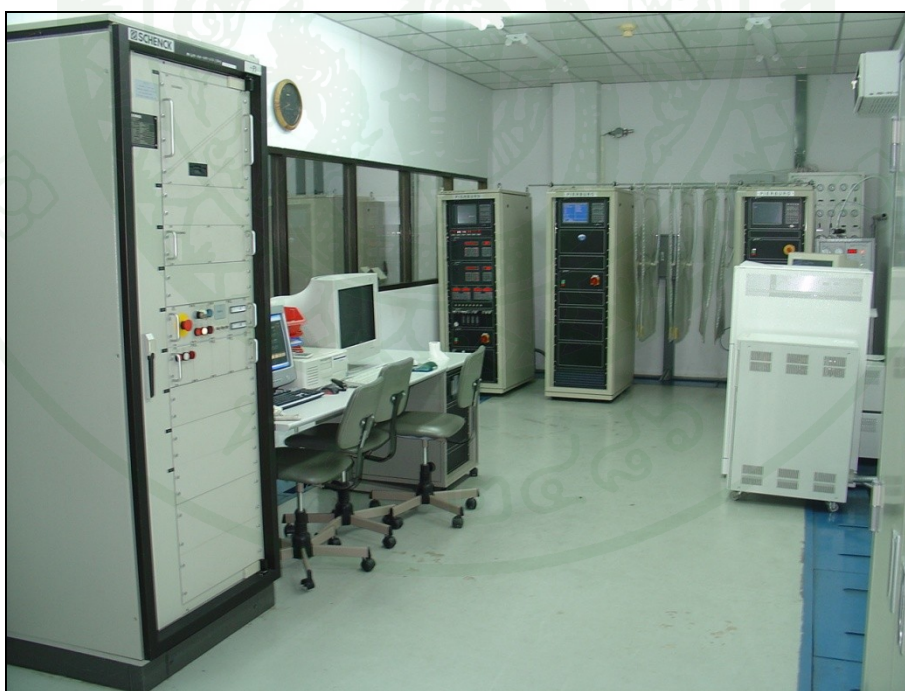
ภาพผนวกที่ ค2 ระบบเครื่องมือวิเคราะห์สารมลพิษจากไอเสีย
