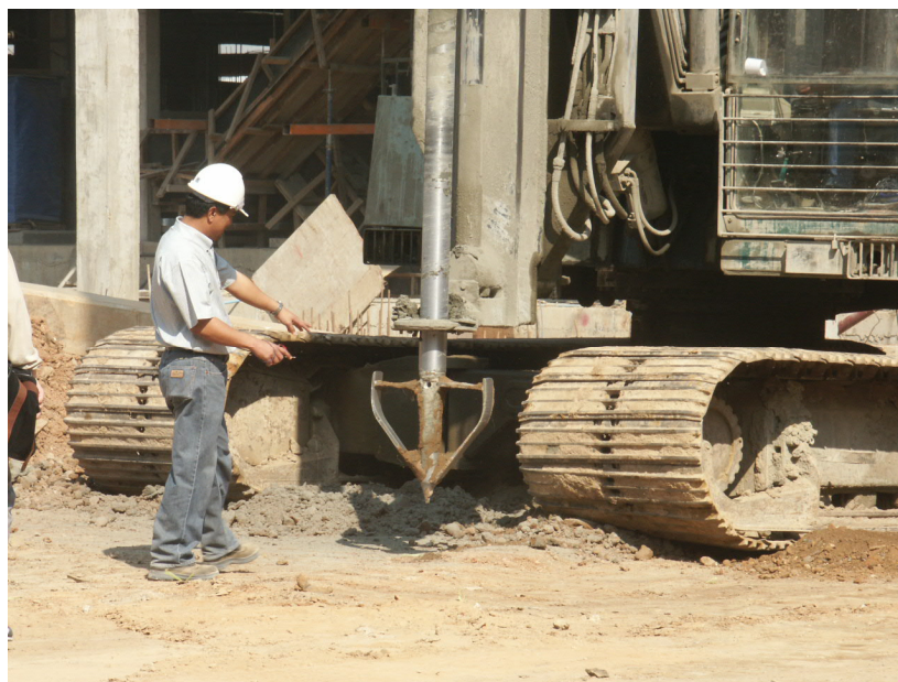
ภาพที่ 2.5 หัวเจาะแบบ Dry Mixing
