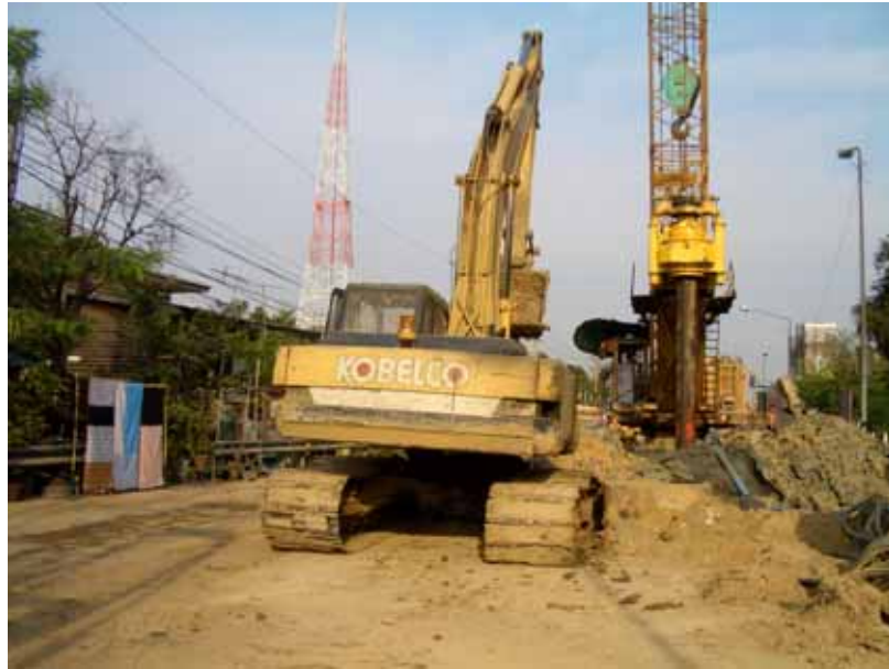
ภาพผนวกที่ ข11 การตรวจวัดการลดระดับความดังเสียงของเศษผ้าในภาคสนาม (เสียงจาก Piling rig)
