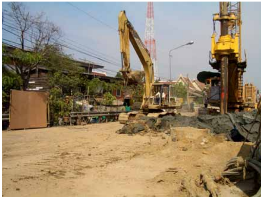
ภาพผนวกที่ ข12 การตรวจวัดการลดระดับความดังเสียงของไม้อัดในภาคสนาม (เสียงจาก Piling rig)
