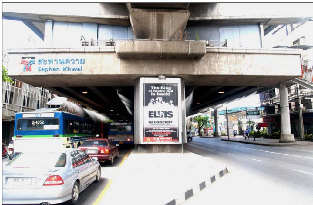
ภาพที่ 16 ลักษณะโครงสร้างสถานีรถไฟฟ้าสะพานควาย
