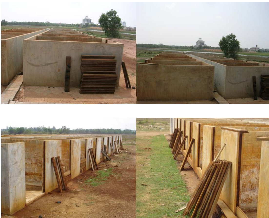
ภาพที่ 8 ก่อผนังคอนกรีตกำแพงชะลอ
