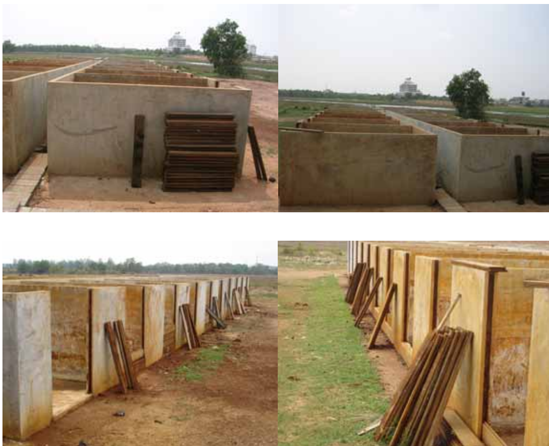
ภาพที่ 8 ก่อสร้างคอนกรีตกำจัดขยะ
