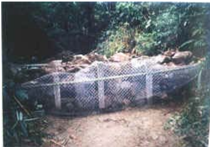
ภาพที่ 7 ลักษณะของฝายผสมผสานแบบตาข่าย
