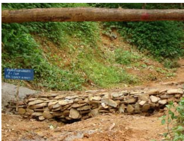
ภาพที่ 8 ลักษณะของฝายผสมผสานแบบหินทิ้ง
