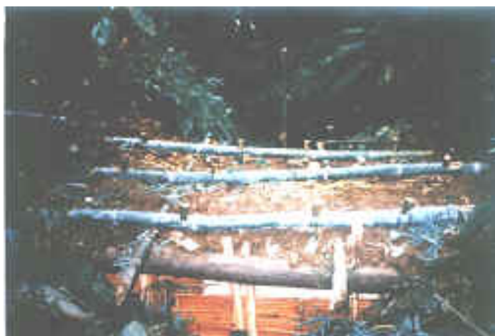
ภาพที่ 5 ลักษณะของฝายผสมผสานแบบไม้ไผ่
