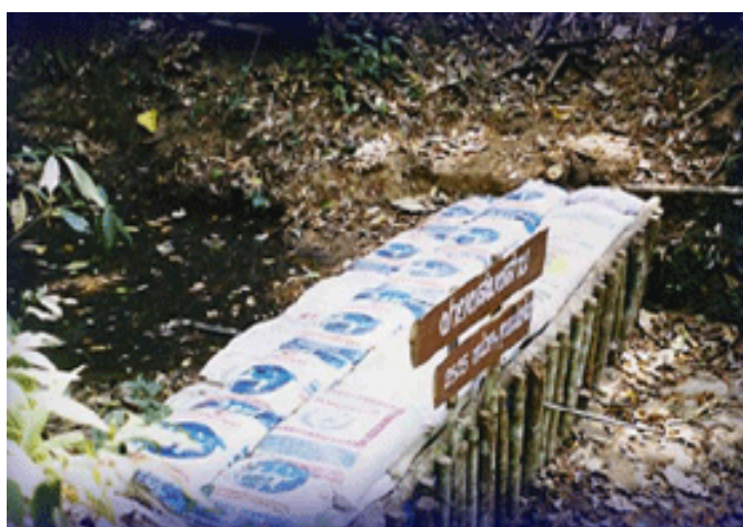
ภาพที่ 6 ลักษณะของฝายผสมผสานแบบกระสอบ
