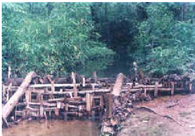
ภาพที่ 9 ลักษณะของฝ่ายผสมผสานแบบภูมิปัญญาชาวบ้าน
