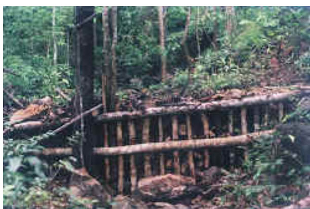
ภาพที่ 4 ลักษณะของฝายผสมผสานแบบคอกหมู
